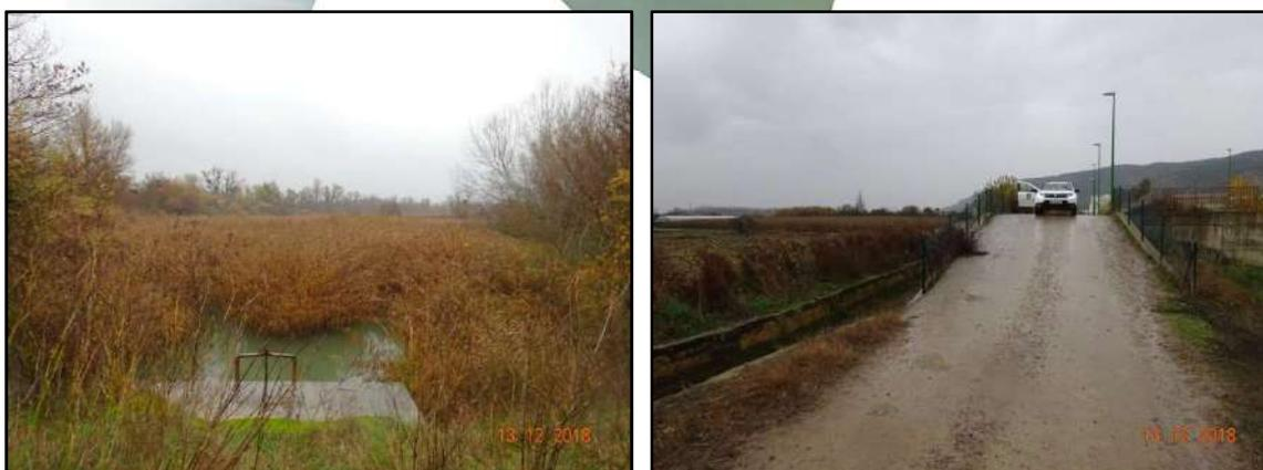
**Ilustración 42.** Figura izquierda: acequia en la zona de **salida de Ramal Hondo y Madre Vieja**, en la zona de las piscinas municipales. Figura derecha: paso elevado de camino rural en la zona norte del casco urbano (camino Ribera), como protección ante las riadas, originadas con frecuencia en el término municipal de Peralta y que pueden llegar al casco urbano de la localidad a través de los meandros de Soto Gil, Madre Vieja y Ramal Hondo.
