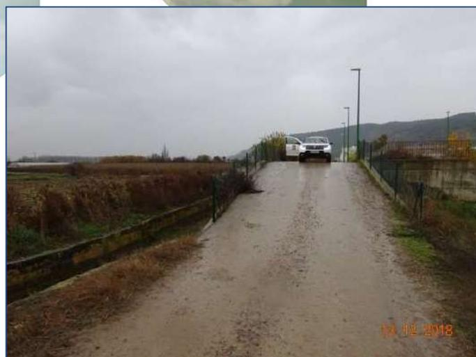
**Ilustración 56.** Camino Ribera. Mota sobrelevada, como protección ante los desbordamientos en la margen izquierda, que se pueden originar aguas arriba, en el término municipal de Peralta.
