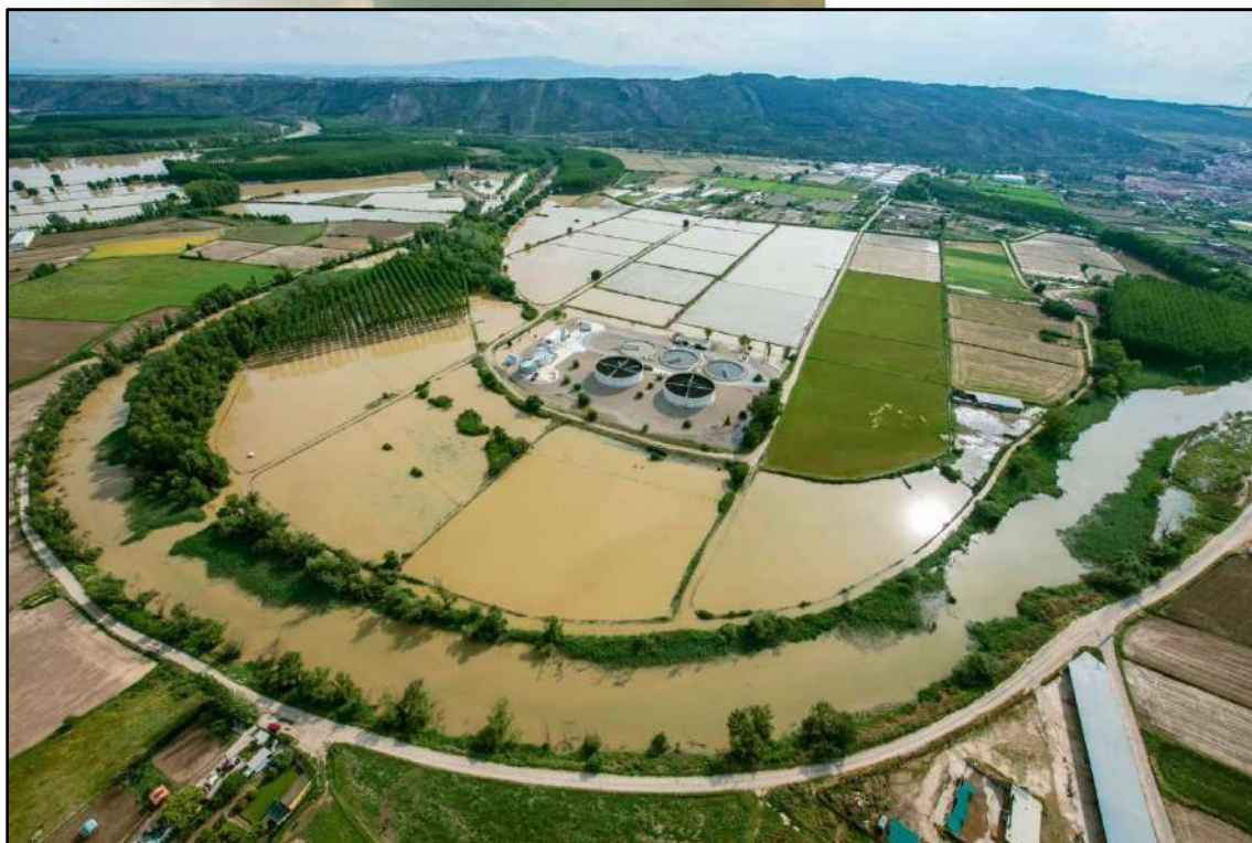
Ilustración 25. Inundación anterior en el Soto Sardillas, donde el perímetro de la EDAR quedó prácticamente rodeado por el agua desbordada. EDAR situada en el centro de la imagen.
