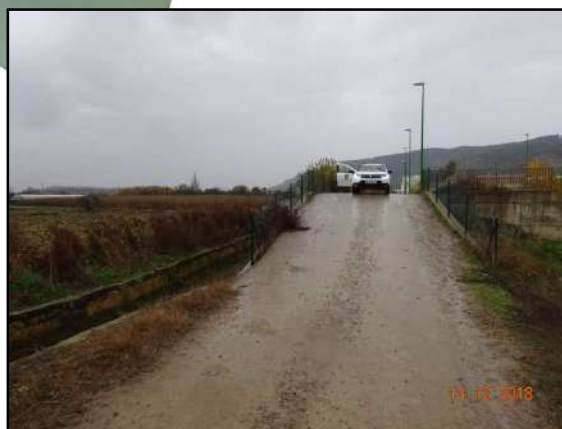
Ilustración 42. Figura izquierda: acequia en la zona de salida de Ramal Hondo y Madre Vieja , en la zona de las piscinas municipales. Figura derecha: paso elevado de camino rural en la zona norte del casco urbano (camino Ribera), como protección ante las riadas, originadas con frecuencia en el término municipal de Peralta y que pueden llegar al casco urbano de la localidad a través de los meandros de Soto Gil, Madre Vieja y Ramal Hondo.
