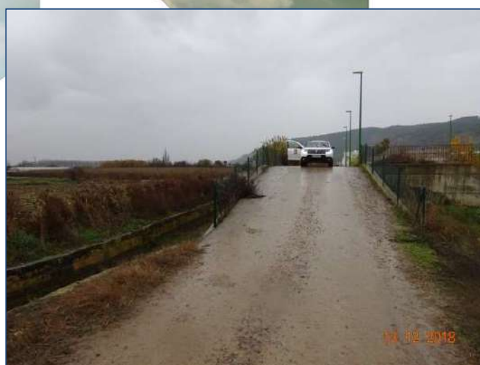
Ilustración 56. Camino Ribera. Mota sobrelevada, como protección ante los desbordamientos en la margen izquierda, que se pueden originar aguas arriba, en el término municipal de Peralta.
