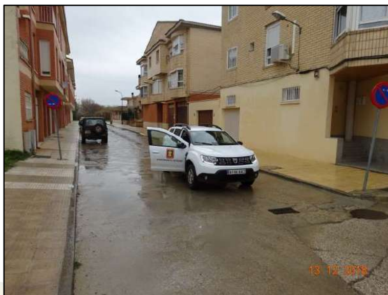
Ilustración 43. Cruce de calle Olite con calle Estajado. Alcantarillado por el que se inicial el retorno de aguas pluviales en situaciones de crecida del Arga. Se trata de uno de los puntos más bajos de la margen izquierda del río aguas arriba del puente. Este punto fue señalado como de especial interés por los técnicos del ayuntamiento durante la visita de campo. Importante su señalización por las afecciones al tráfico en la zona.
