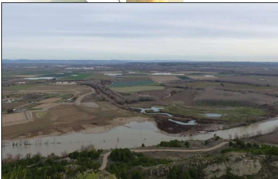
Ilustración 28. Imágenes de inundaciones recientes (año 2018) en la zona de confluencia de los ríos Arga y Aragón, con los trabajos del proyecto de la CHE ya en marcha. En la imagen superior ya se aprecia cómo se ha ampliado la superficie de la llanura de inundación. Por su parte, en la imagen inferior, en el lado izquierdo se observa ya la ubicación de la nueva mota, retranqueada y en construcción. En el lado derecho se observan también los nuevos humedales creados.
