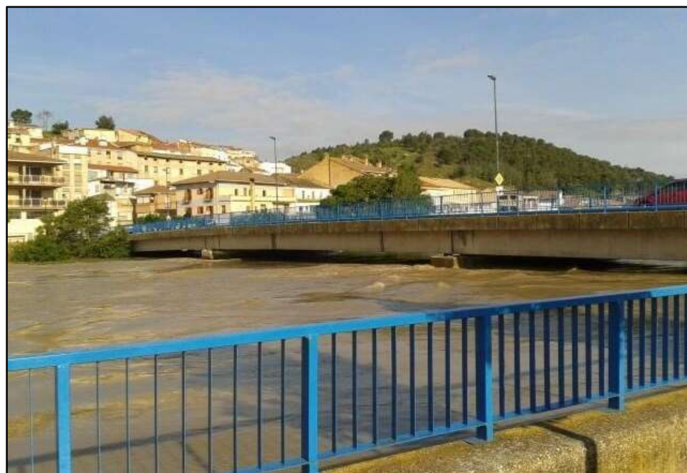
Ilustración 29. Imágenes del puente de la carretera NA-6630, sobre el cauce del Arga (en estado normal en la imagen superior, y en una crecida anterior en la imagen inferior)
