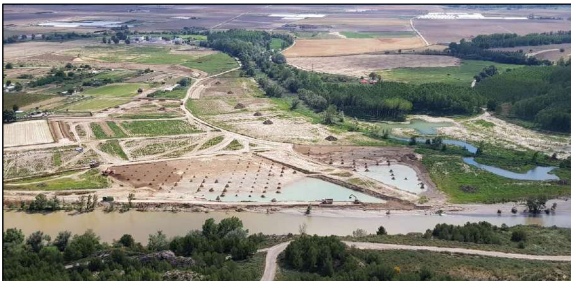
Ilustración 26. Imagen del desarrollo de los trabajos del proyecto ( https://twitter.com/CH_Ebro , foto del estado de la obra a fecha 17/06/2018).
