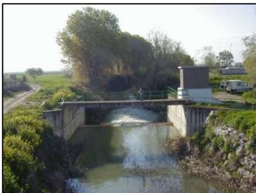
**Ilustración 10.** Estación de aforo del río Cidacos en Olite, propiedad del Gobierno de Navarra. Foto obtenida de GAN-NIK
